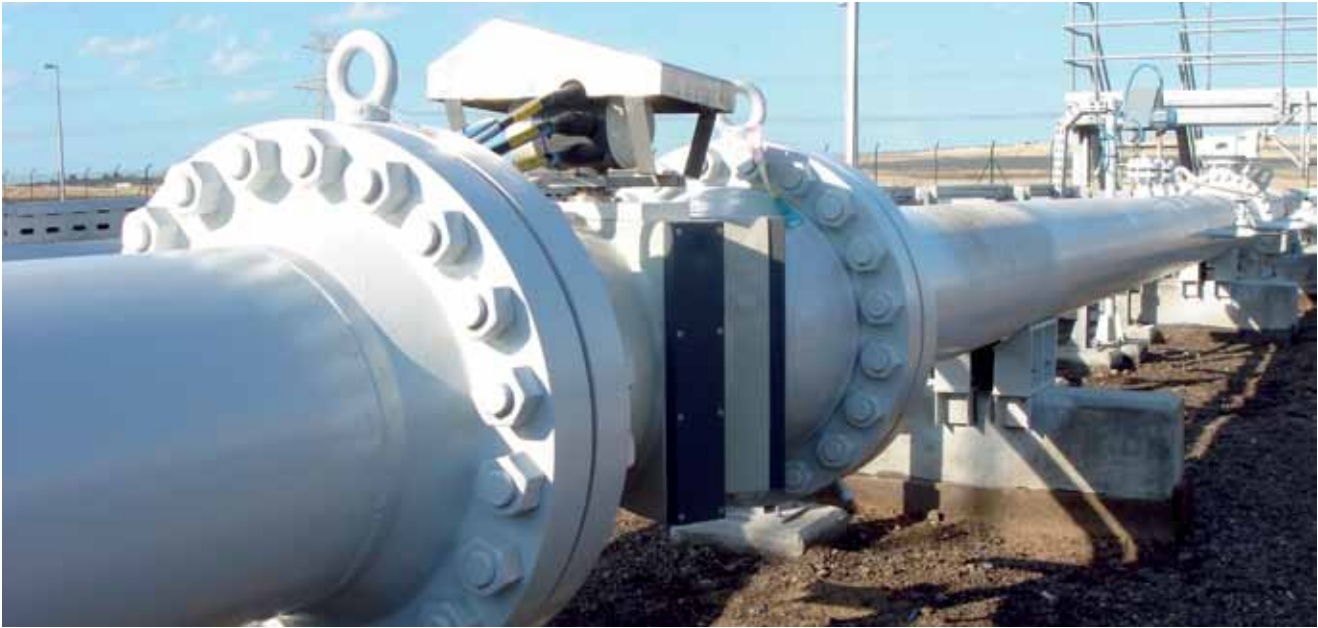
Bild 10: Die Gaszählergehäuse sind Kleinserienteile, die in nur 12 Wochen in verschiedenen Größen für 6- bis 36-Zoll-Rohre gegossen wurden [56].
