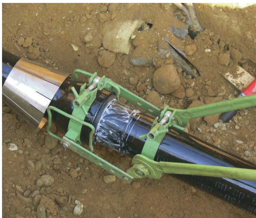
Bild 3: Montage einer Muffenverbindung DN 125 in einem Berstlining-Projekt.
