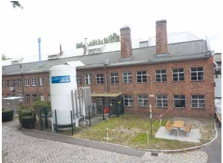
Vacucast von Außen: Der rote Ziegelbau verfügt über 5000 Quadratmeter Produktionsfläche. Aktuell werden hier rund 200 bis 220 000 Gussteile im Jahr gefertigt.
