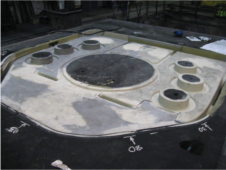
Bild 3: Die Form des Maschinenträgers mit bereits eingelegten Kernen.
